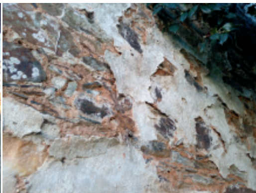
Fisuras, desprendementos e disolución dos revocos. Fonte: elaboración propia.
