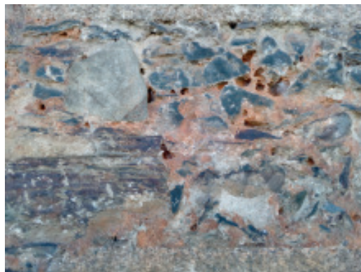
Alveolización da argamasa no muro norte. Fonte: elaboración propia.
