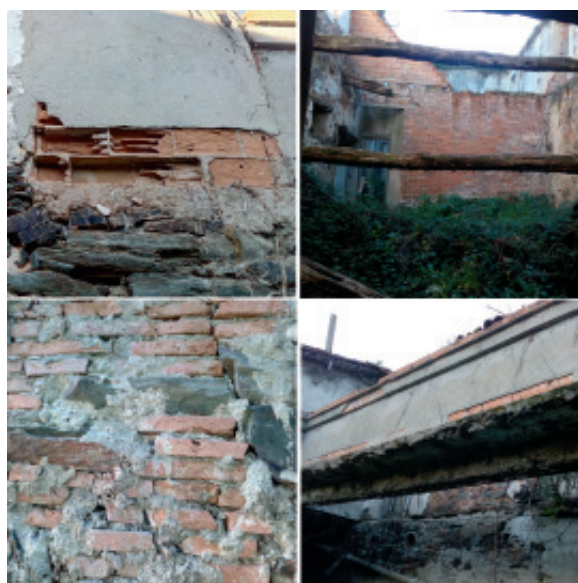
Ladrillos de distintas épocas presentes na estrutura. Fonte: elaboración propia.
