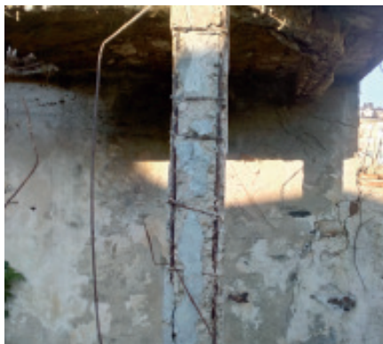
Estado da columna que sostén o balcón da parede sur. Fonte: elaboración propia.
