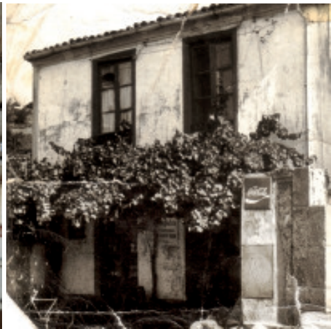
Fig. 46 Antiga construción de Bodegas Barral, en pé ata 1973.
