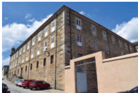
Fig. 11. Fachadas meridional y oriental del Seminario. Fotografía del autor.
