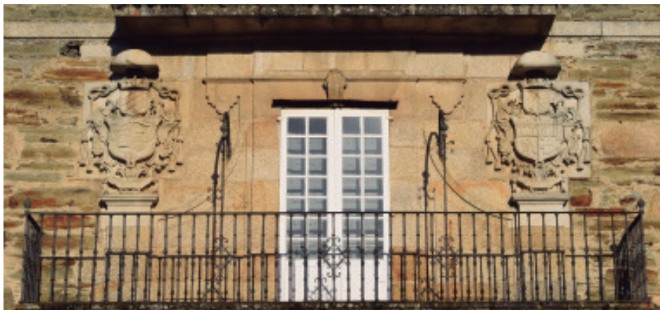
Fig. 9. Parte central del primer piso de la fachada del Seminario. Fotografía del autor.
