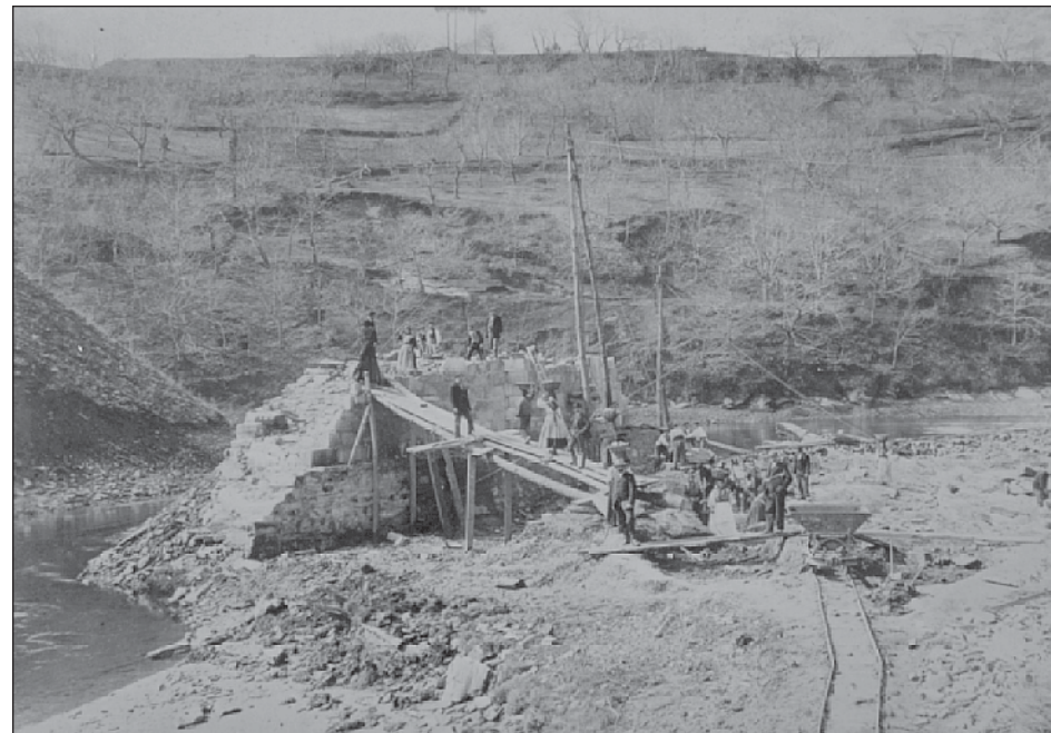
Obras de variación do cauce da ría para o trazado do ferrocarril a Ferrol. Aprécianse varias mulleres traballando en funcións de carrexo.
