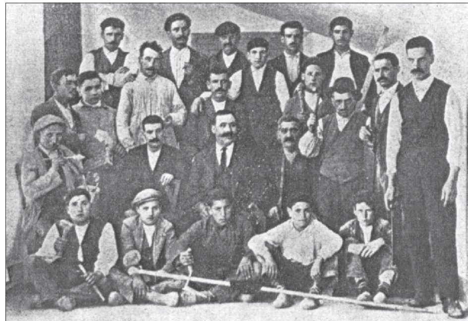
Obreiros que traballan na nova casa residencia dos franciscanos, por 1919, xunto co contratista.
